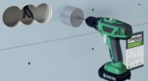
После монтажа звукоизоляционного гипсокартона Gipsofon ПЛУК в нем коронкой просверливается отверстие в месте установки подрозетника.
