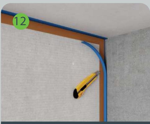
После установки звукоизоляционных панелей SoundGuard Premium излишки звуко-виброблокирующей подложки SoundGuard ВиброСтоп 25 удаляются.
