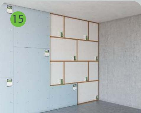
Звукоизоляционный гипсокартон Gipsofon ПЛУК монтируется без зазоров между листами. Расход саморезов SoundGuard ГП 3,9x30 составляет не менее 22 шт./м<sup>2</sup>.
