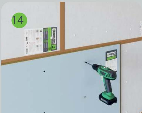
Звукоизоляционный гипсокартон Gipsofon ПЛУК монтируется совместно с мембраной и крепится к поверхности звукоизоляционных панелей саморезами SoundGuard ГП 3,9x30
