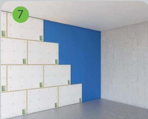
Звукоизоляционные панели SoundGuard Premium устанавливаются вразбежку и крепятся к стене с помощью акустических дюбель-гвоздей SoundGuard DA-P.
