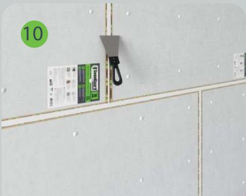
После установки всех панелей герметиком при помощи шпателя промазываются все швы между панелями и места установки дюбель-гвоздей SoundGuard DS-P.
