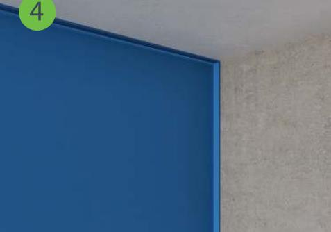
Подложка заводится на потолок, пол и соседнюю стену на величину толщины устанавливаемых звукоизоляционных панелей SoundGuard.
