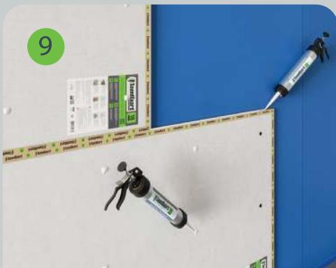
Виброакустический герметик SoundGuard Seal наносится на грани панелей в процессе их монтажа и в местах установки дюбель-гвоздей.
