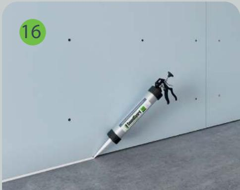
Между торцами листов гипсокартона и поверхностями пола, стен и потолка остается зазор 3 - 5 мм, который впоследствии заполняется виброакустическим герметиком SoundGuard Seal.
