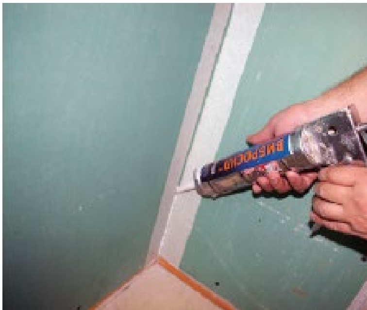
Рисунок 24. Заполнение швов герметиком Вибросил.
