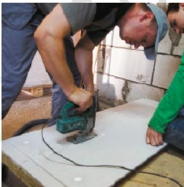
Рисунок 21. Подрезка панелей ЗИПС.
