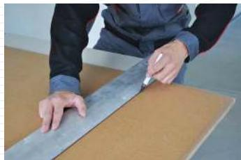
**1** Разметка звукоизоляционных панелей PhoneStar перед резкой.
