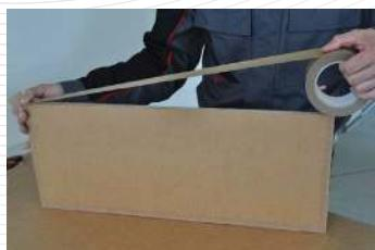
**3** После резки панель повернуть срезом вверх и место «среза» проклеить клейкой лентой Wolf Tape.
