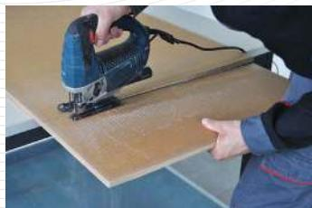
**2** Резку звукоизоляционных панелей производить в горизонтальной плоскости - электро-лобзиком, отрезной машиной или ножковкой по дереву.
