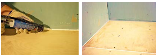
Стыки по периметру заполняются герметиком «Вибросил»
