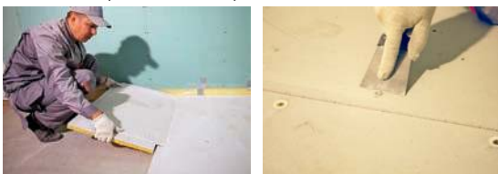
Отверстия под саморезы зачищаются шпателем
