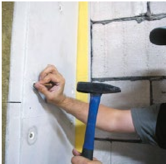
Рисунок 20. Крепление панели ЗИПС через виброузел.
