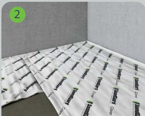
Поверх минеральных плит раскатывается материал SoundGuard Cover с нахлестом друг на друга примерно на 10 – 15 см, а также на стены на толщину стяжки.
