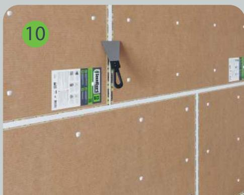
После установки всех панелей, герметиком при помощи шпателя промазываются все швы между панелями и места установки дюбель-гвоздей SoundGuard DA-P.
