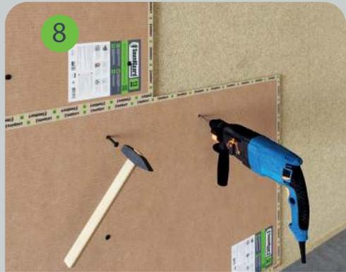
Акустические дюбель-гвозди забиваются в предварительно просверленные (сквозь панель) отверстия в стене и утапливаются в теле панели на 1 мм. На одну звукоизоляционную панель требуется не менее 12 дюбель-гвоздей SoundGuard DA-P.
