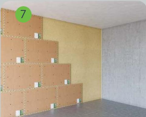
Звукоизоляционные панели SoundGuard ЭкоЗвукоИзол устанавливаются вразбежку и крепятся к стене с помощью акустических дюбель-гвоздей SoundGuard DA-P.
