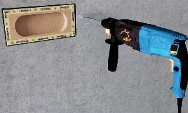
Для вывода розеток в стене выштробить углубление и поместить в него звукоизоляционный подрозетник SoundGuard ИзоБокс Премиум в один уровень с плоскостью стены.
