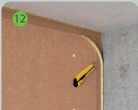
После установки звукоизоляционных панелей SoundGuard ЭноЗвукоИзол излишки виброакустической подложки SoundGuard VibroRoll удаляются.
