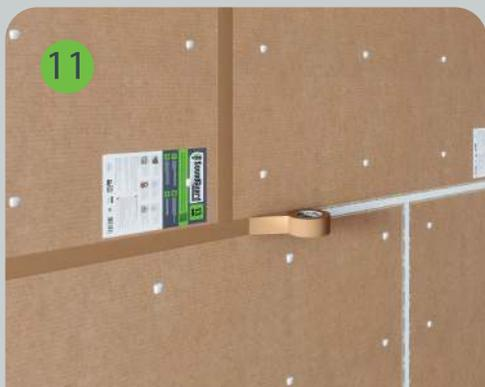
Швы между звукоизоляционными панелями дополнительно проклеиваются клейкой лентой SoundGuard Tape.
